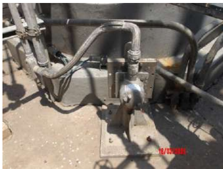
ภาพที่ 2.2-35 H 2 S Gas Detector
