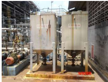
ภาพที่ 2.2-19 Slop Oil Tank เพื่อรวมครบน้ำมัน จากบ่อกักน้ำเสีย CPI/IAF
