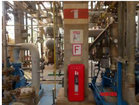
ภาพที่ 2.2-32 อุปกรณ์ดับเพลิง (DHT)
