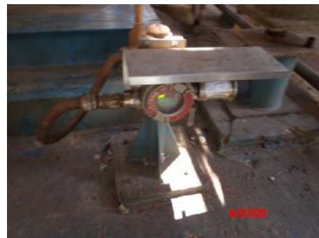
ภาพที่ 2.2-36 Hydrocarbon Gas Detector
